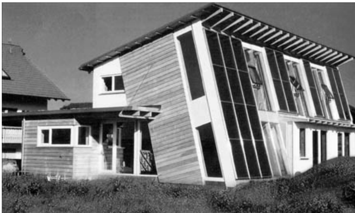
Рис. 1. Жилой дом, обладающий признаками экологической безопасности: отопление и энергоснабжение обеспечиваются солнечными элементами, естественная вентиляция – посредством открываемых и регулируемых окон, при строительстве самого дома использовалось главным образом необработанное дерево
