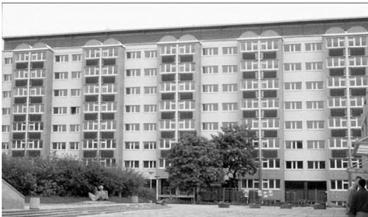
Рис.2. Жилой дом, где каждая квартира оборудована солнечной батареей, установленной вертикально непосредственно на фасаде. Система является дополнительным источником энергии для системы отопления и горячего водоснабжения
